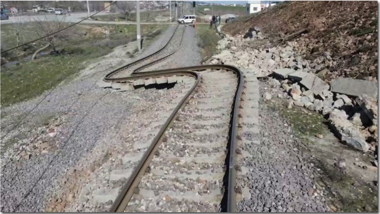
Fotoğraf 1: Kahramanmaraş Türkoğlu – Gaziantep Islahiye arası tren raylarındaki deformasyon (Kaynak : AA) (1)
