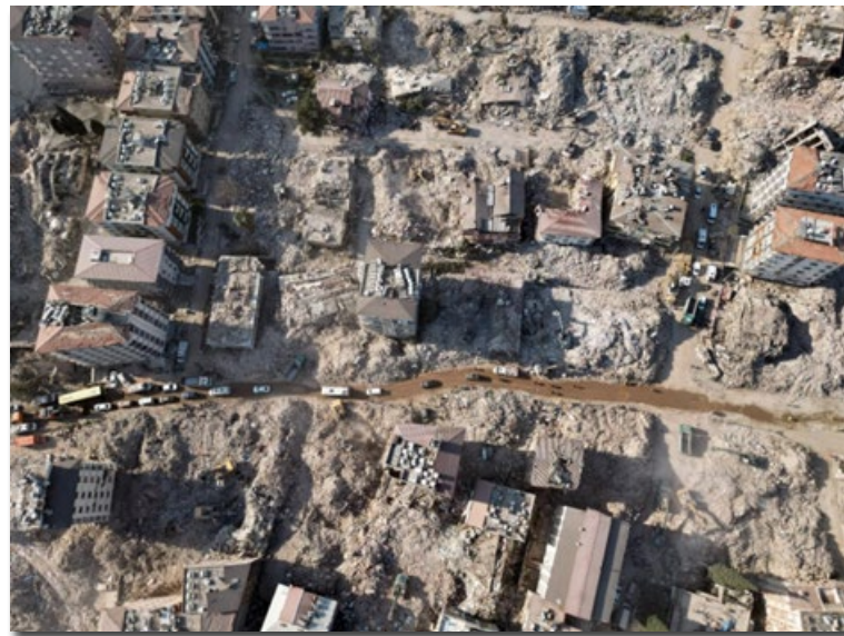
Fotoğraf 2: Betonarme ol(a)mamış binaların göçmesi (Fotoğraf : Erhan Sevenler -AA) (2)
