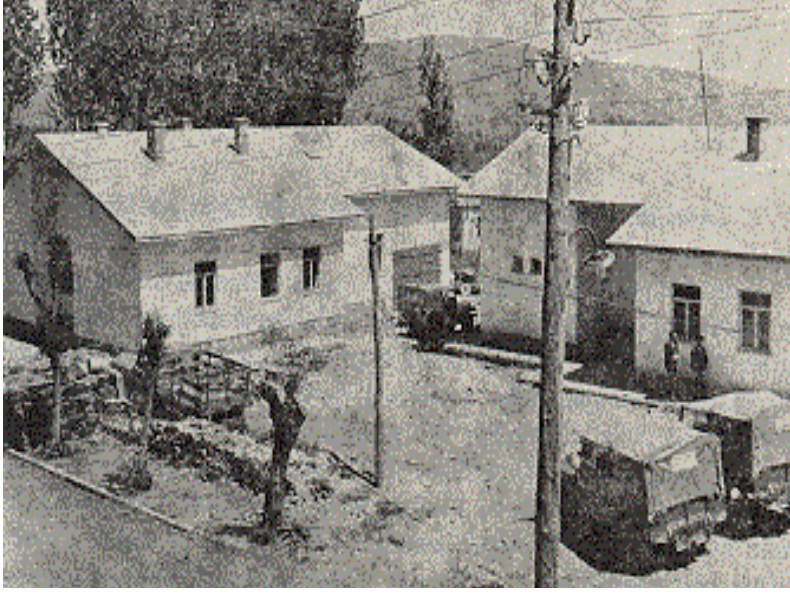
Şekil 3: Muş İlinde Yapılan Köy Tipi Sağlık Ocağı ve Lojmanı
